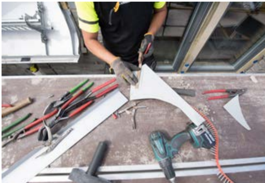
En plåtslagare lägger tak på ett parhus under byggnation. Foto: Fredrik Sandberg/TT
