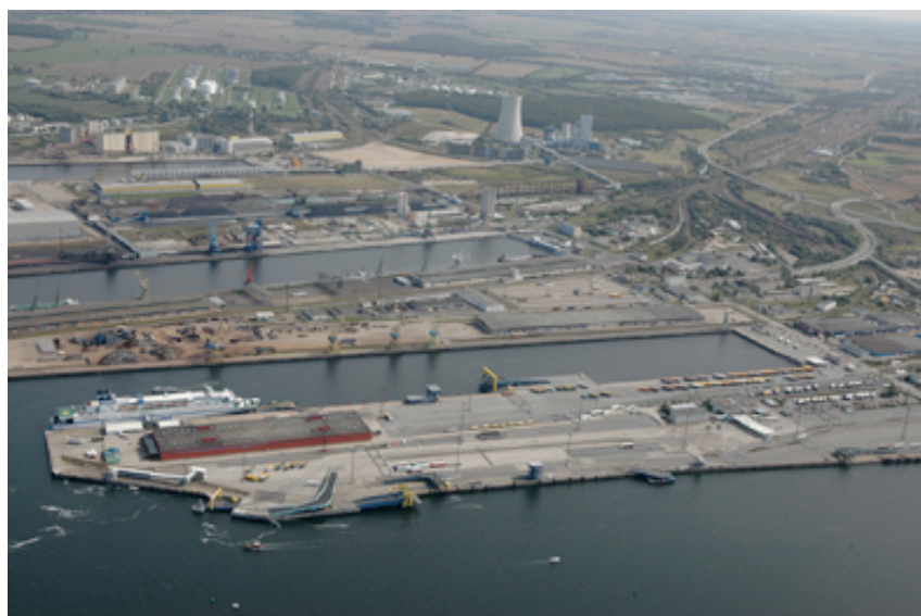
Byggeriet af den nye BorderShop er i fuld gang ved havnen i Rostock
