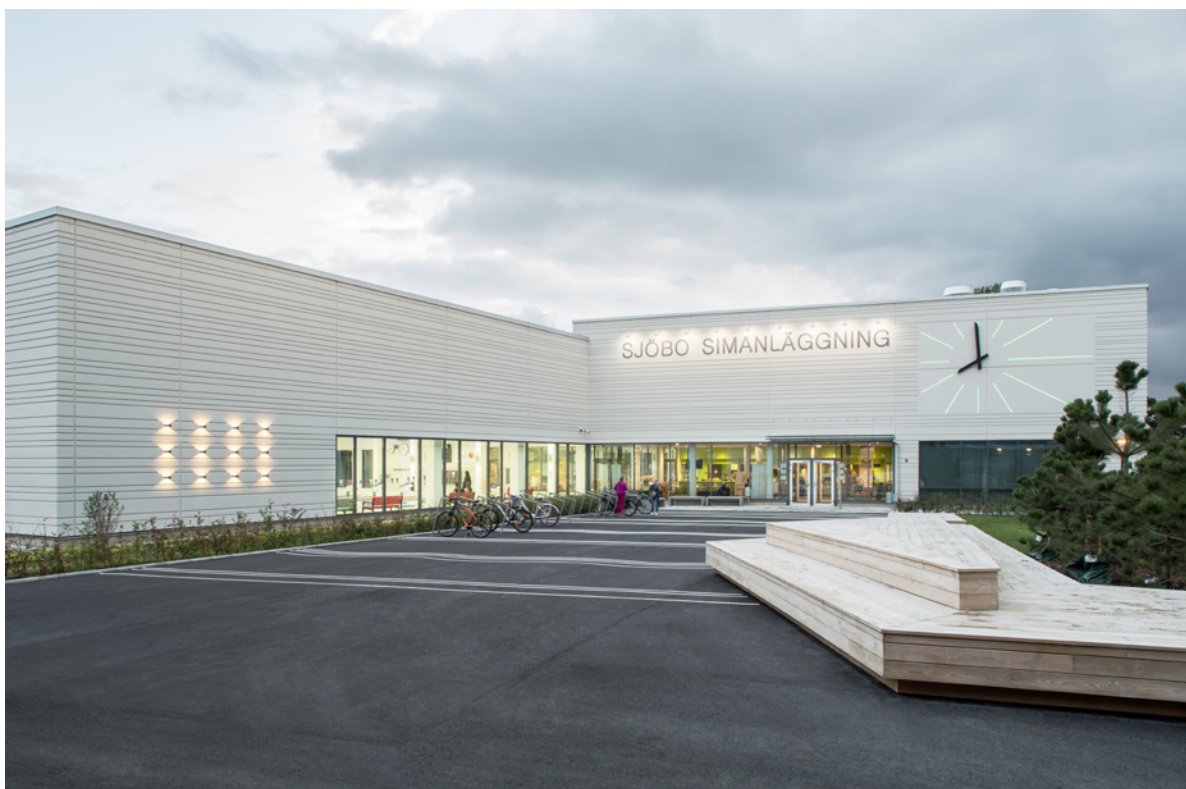
Foto: Kentaroo Tryman. Sjöbo Simanläggning exteriör.
