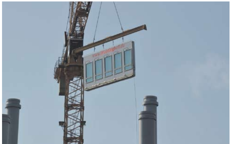
Auf der Baustelle in Münster werden die vorproduzierten Wandelemente von den Montageteams von Brüninghoff eingesetzt.
