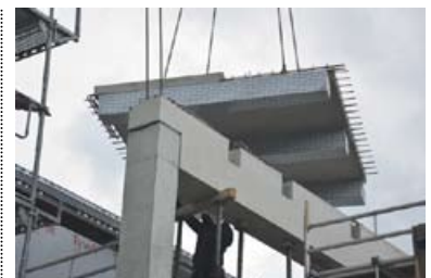
Das Holz der Hybriddecken wird ebenfalls ab Werk mit einer Folie geschützt. Der Beton der Hybriddecke ist durch Verwendung einer speziellen Betonrezeptur wasserundurchlässig.
